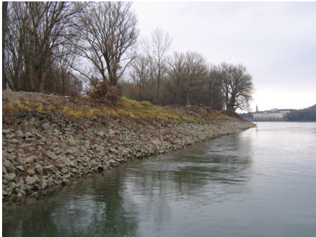
Abbildung 3: Vor der Umsetzung des LIFE-Projektes war das Donauufer gegenüber von Hainburg a. d. Donau durch einen großen Blocksteinwurf stabilisiert (21.11.2005). Foto: © Christian Baumgartner/Nationalpark Donau-Auen
