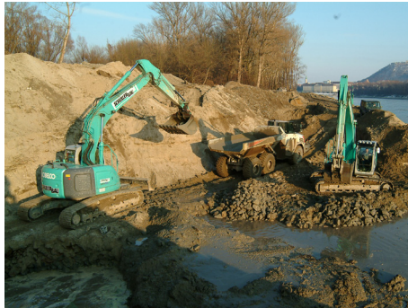
Abbildung 4: Im Zuge der Baumaßnahmen wurden ca. 50.000 m³ Wasserbausteine abgetragen und per Schiff aus dem Nationalpark entfernt (14.02.2006). Foto: © Georg Frank/Nationalpark Donau-Auen
